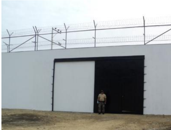
Construcción nueva puerta de ingreso
