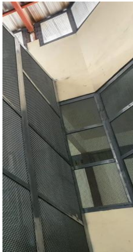
Escalera de patio interior recubierta de malla acerada subida a 2da planta
