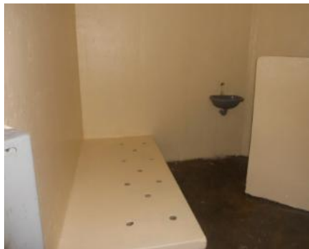
Interior Celda Tipo
