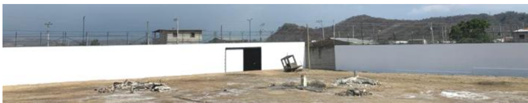
Cerramiento perimetral frontal
