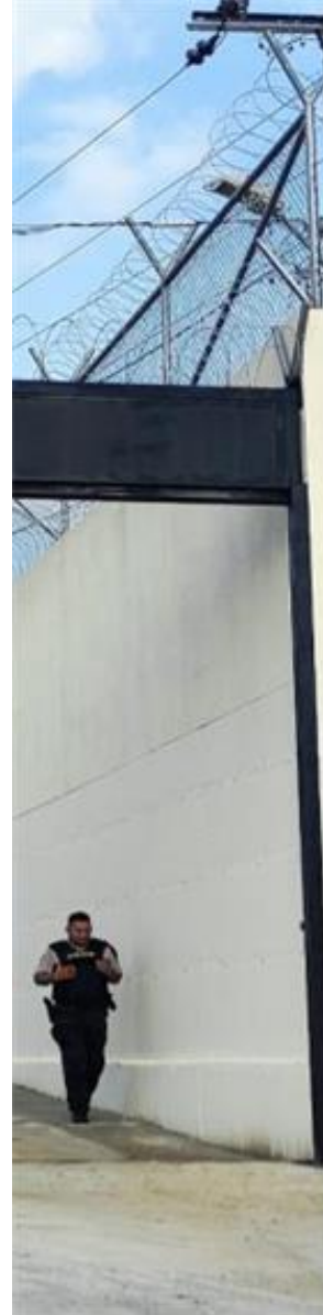
Nuevo cerramiento y adecuación de cerramiento
