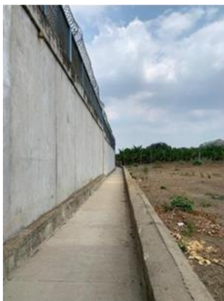
Acera Perimetral exterior
