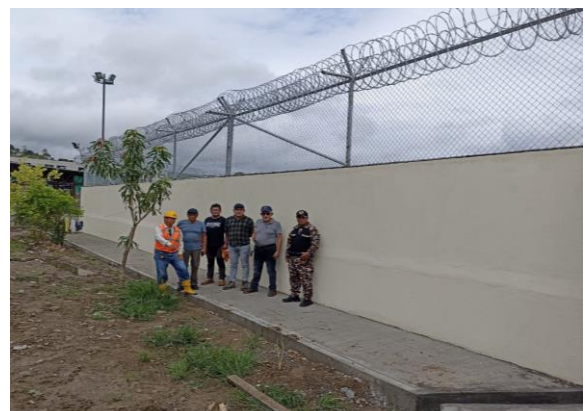
Imagen 20 Fachada interior – Cerramiento nuevo y vereda CPL Esmeraldas Nro. 2.
