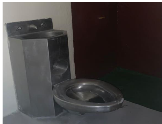
Imagen 13 Batería sanitaria celda cambiada CPL Guayas Nro. 3.
