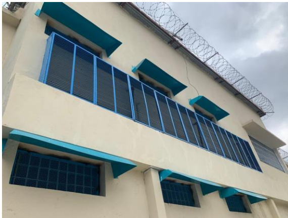
Imagen 8 Fachada reparada pabellón 6 CPL Guayas Nro. 1.
