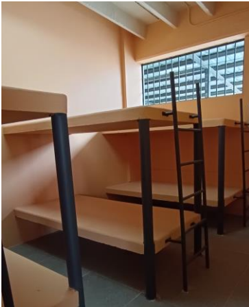
Imagen 16 Literas de hormigón construidas celda adecuada (nueva) CPL Guayas Nro. 2.
