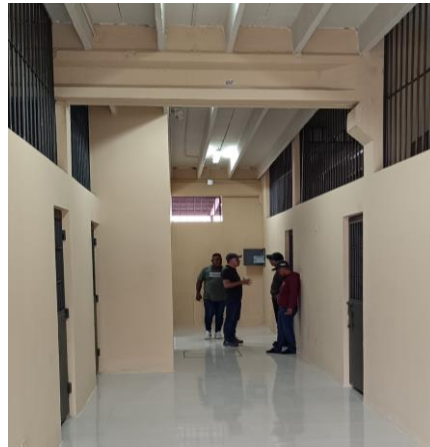
Imagen 17 Batería sanitaria celda adecuada CPL Guayas Nro. 2.
