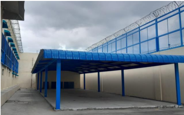
Imagen 10 Taller y baterías sanitarias patios reparada CPL Guayas Nro. 1.
