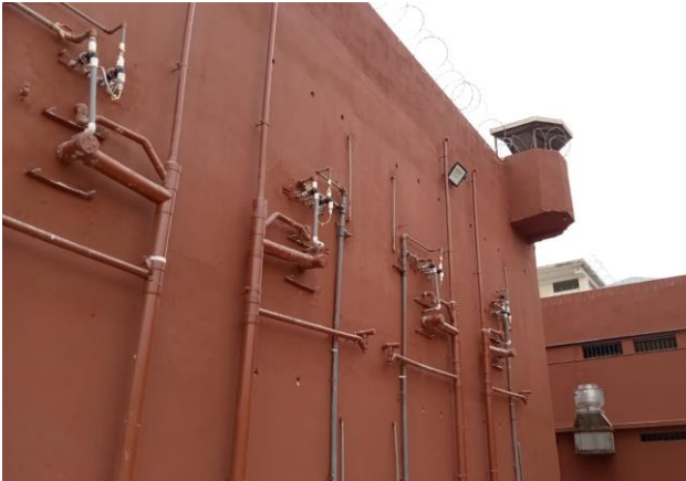
Imagen 12 Fachada posterior - Instalaciones hidrosanitarias reparadas CPL Guayas Nro. 3.
