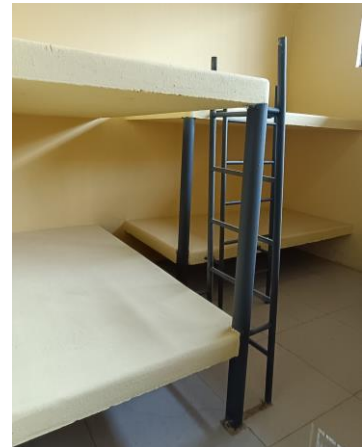
Imagen 18 Literas de hormigón construidas celda readecuada CPL Guayas Nro 2.
