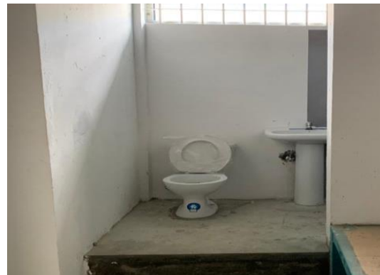
Imagen 11 Batería sanitaria celda reparada CPL Guayas Nro.1.
