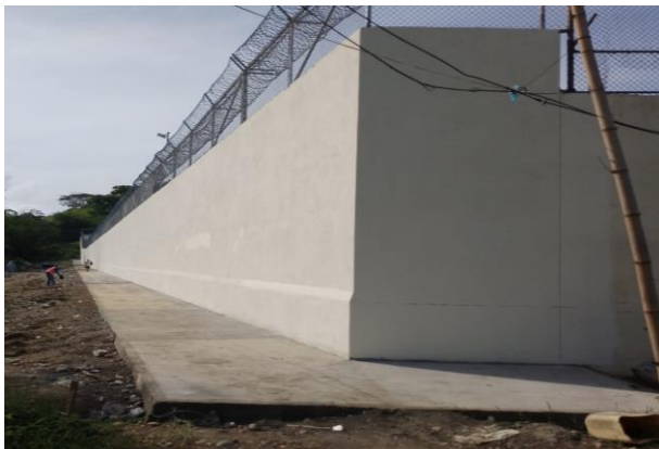
Imagen 19 Fachada posterior – Cerramiento nuevo y vereda CPL Esmeraldas Nro. 2.
