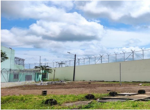
Imagen 21 Fachada interior – Cerramiento nuevo CPL Santo Domingo Nro. 1.
