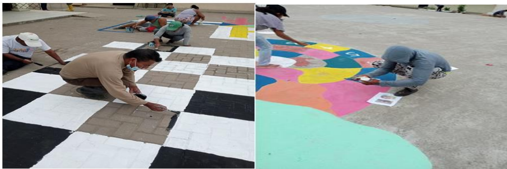
Imagen 32 Apoyo en el mantenimiento y adecuaciones en establecimientos educativos.
