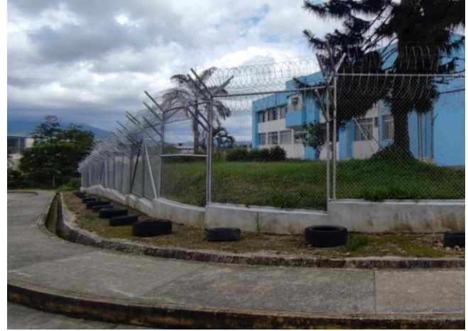
Imagen 22 Fachada interior – Cerramiento nuevo de malla CPL Santo Domingo Nro. 1.
