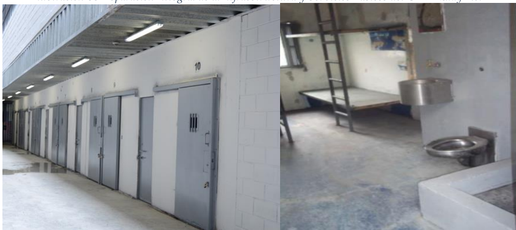
Ilustración 33 Reparación Integral de la Infraestructura y Servicios Básicos del CPL Azuay No. 1
